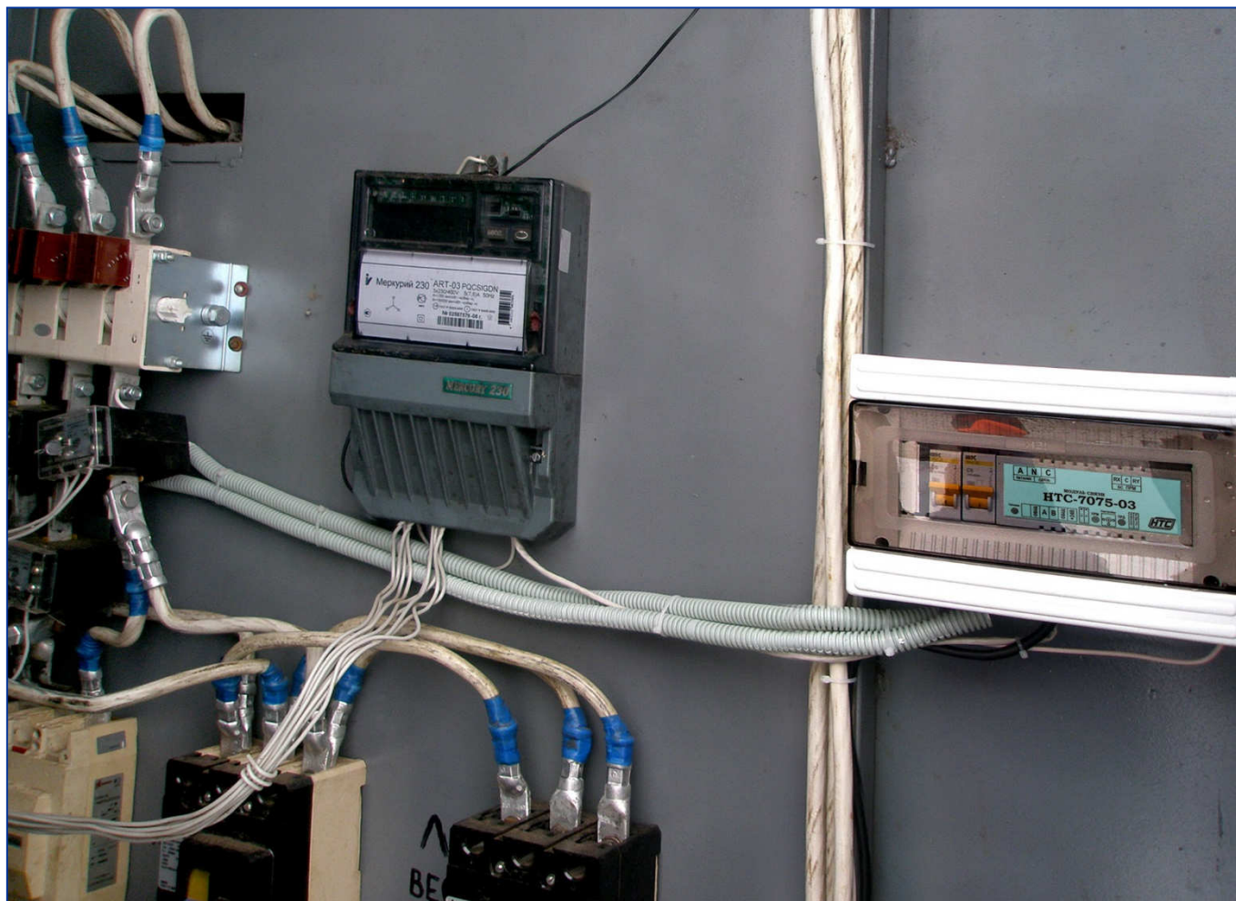
Модуль связи HTC-7075-03 на КТП ЧЭС.
